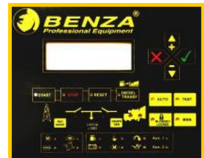
Fig.2 Controlerul digital al panoului de transfer sarcina
